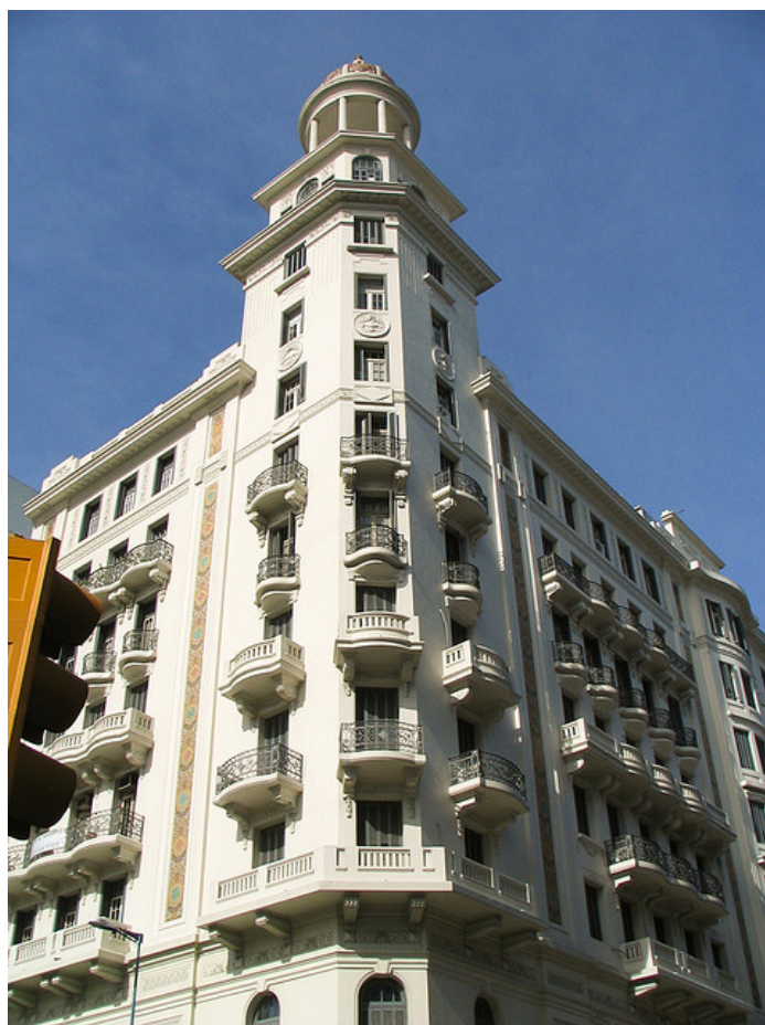
Edificio Rex, en Avda. 18 de Julio esq. S.E. con Julio Herrera y Obes. En el último piso vivió Esther Correch y Alfredo Cáceres, donde recibieron en sus tertulias a la intelectualidad montevideana de la época.
